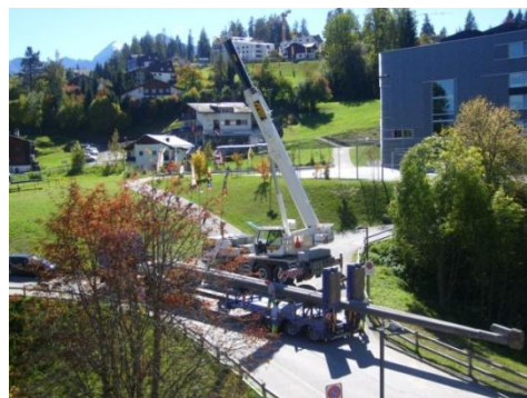
Abbau und Erdverlegung der Hochspannungsleitung Axpo Hydro Surselva AG (Fotos Dr. H. Baumberger)
