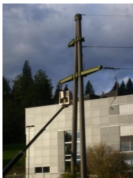
Abbau und Erdverlegung der Hochspannungsleitung Axpo Hydro Surselva AG (Fotos Dr. H. Baumberger)
