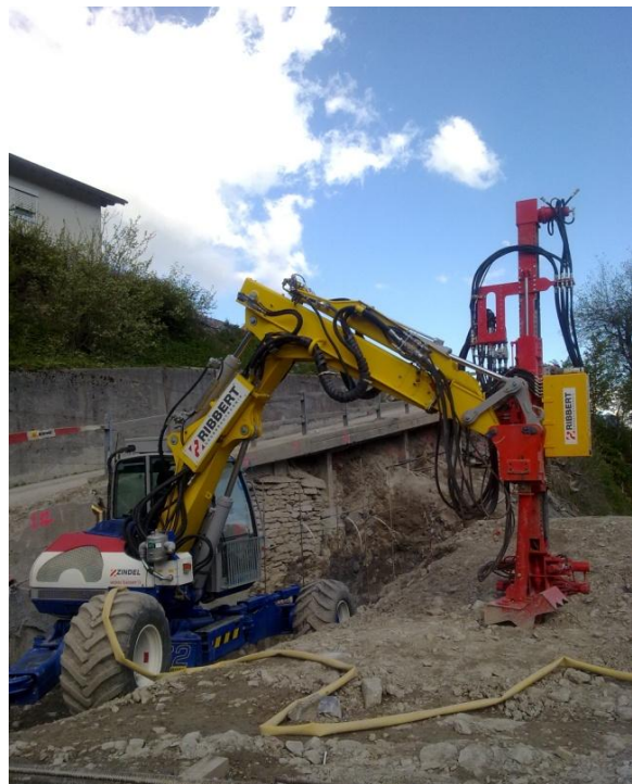
Setzen der Anker für Befestigung Zufahrtstrasse Stenna
