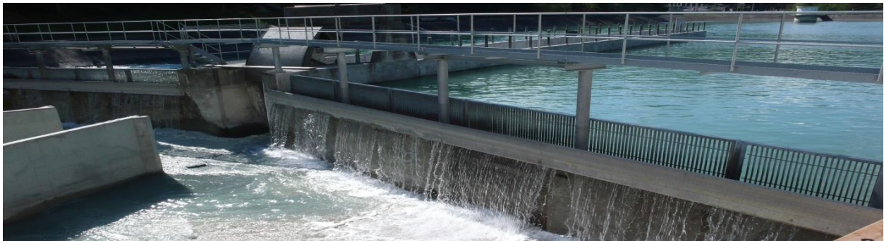
Stauanlage Ual da Mulin im Sommerbetrieb bei Speisung über Buligna und Lag Tiert
