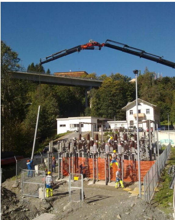
Demontage der letzten Abspanngerüste der 60 kV Leitung
