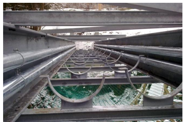
Rohrbrücke Felsbach Schlucht, 28.11.2010
