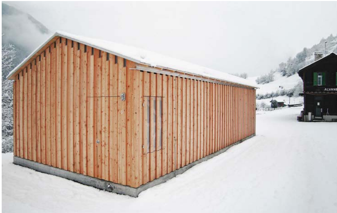
Der vorbetonierte Sockel in Sichtbetonqualität schützt die Fassade vor mechanischer Beschädigung.
