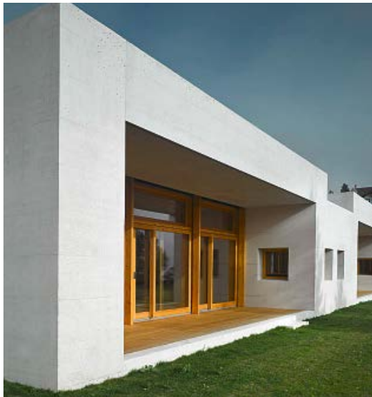
Der Bau zeigt auf, wie Beton und einheimisches Holz gut kombiniert werden kann. Bild: Martin Guggisberg, Zürich
