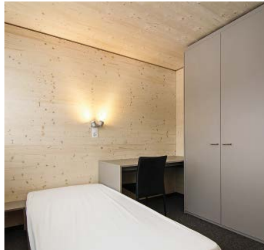
Die Elemente wurden im Werk mit den fertigen Oberflächen hergestellt und anschliessend auf der Baustelle aufgerichtet.
