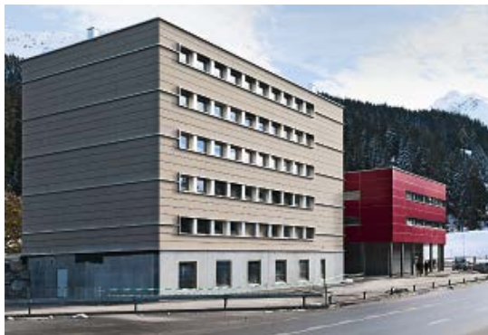
Das rund 18 Meter hohe Personalhaus weist innen und aussen brennbare Oberflächen auf.
